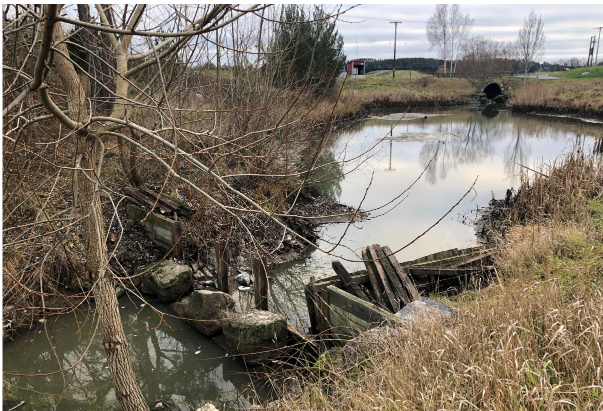
Foto 8. Den övre dammen med resterna av utloppsdämet. Foto Jonas Edlund 2018-11-22.
