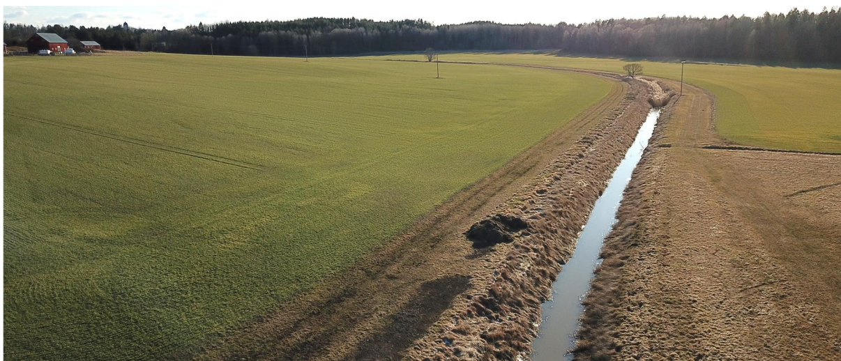
Foto 1. Manhemsån uppströms Djurövägen. Sträckan är omgrävd och sänkt och rinner i ett dike kantat av flack åkermark, ett typiskt utseende för vattendraget uppströms golfbanan. Bilden har spridningstillstånd ur totalförsvarsynpunkt, Lantmäteriets ärendenummer LM2020/001762. Foto Jonas Edlund 2019-03-11.
