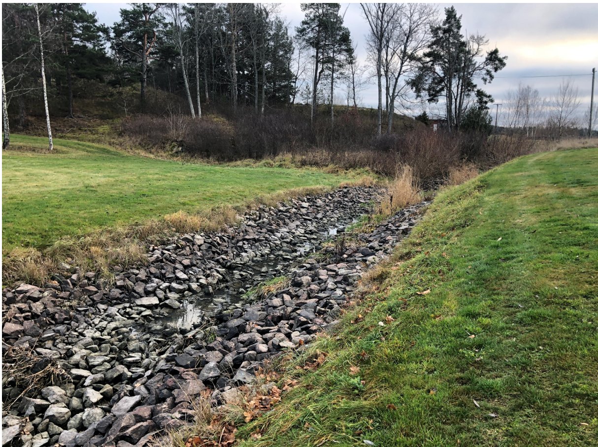
Foto 7. Vattendragssträckan med krossmaterial närmast nedströms den övre dammen. Foto Jonas Edlund 2018-11-22.
