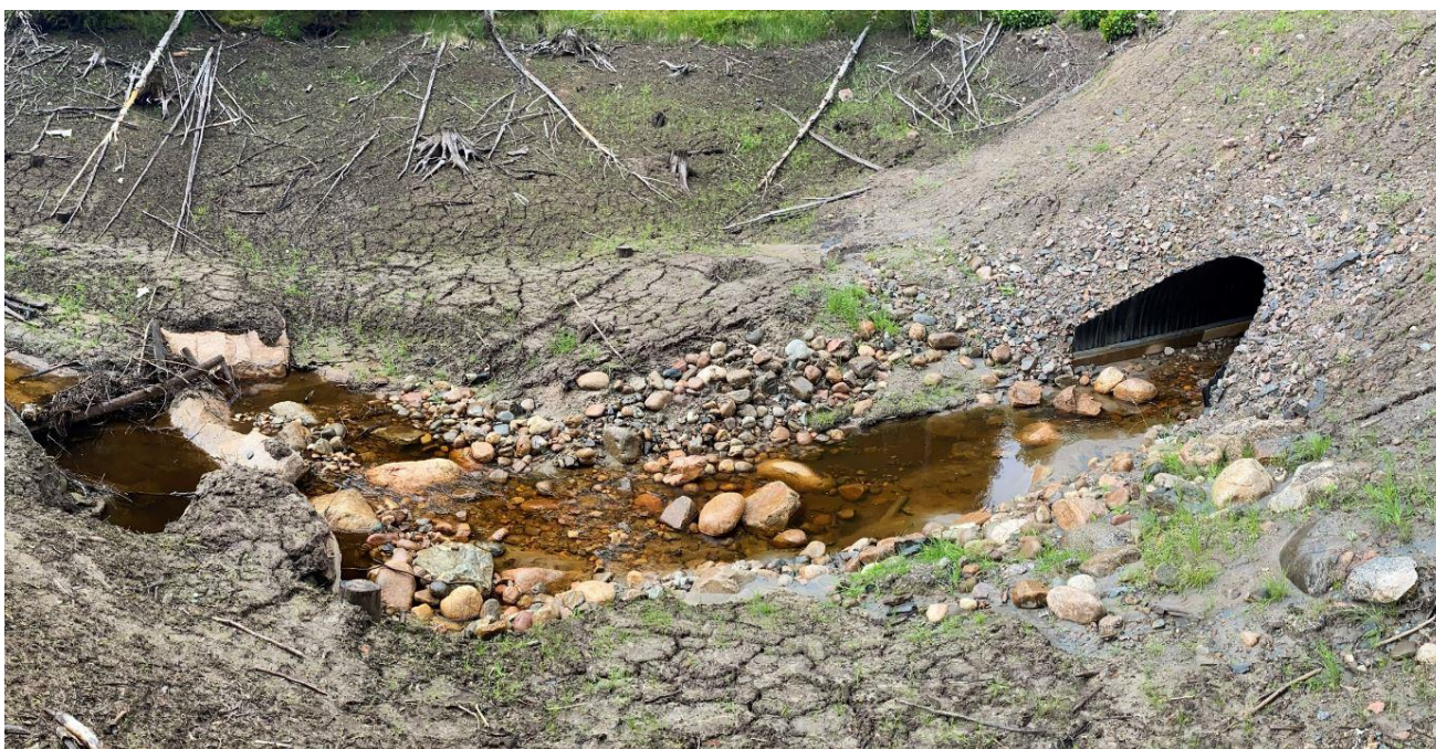
Figur 13.2. Exempel på en nyinstallerad halvtrumma där botten där biotopvård skett genom utläggning av natursten och grus. Bild: Norconsult AB, 2020.
