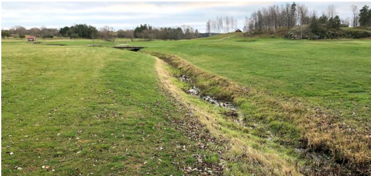
Figur 3. Manhemsåns dikesfåra nedströms det nedre dammsystemet. Denna sträckning föreslås läggas igen och ersättas med en meandrande fåra omgiven av översvämningssmarker. Foto Jonas Edlund 2018-11-22.
